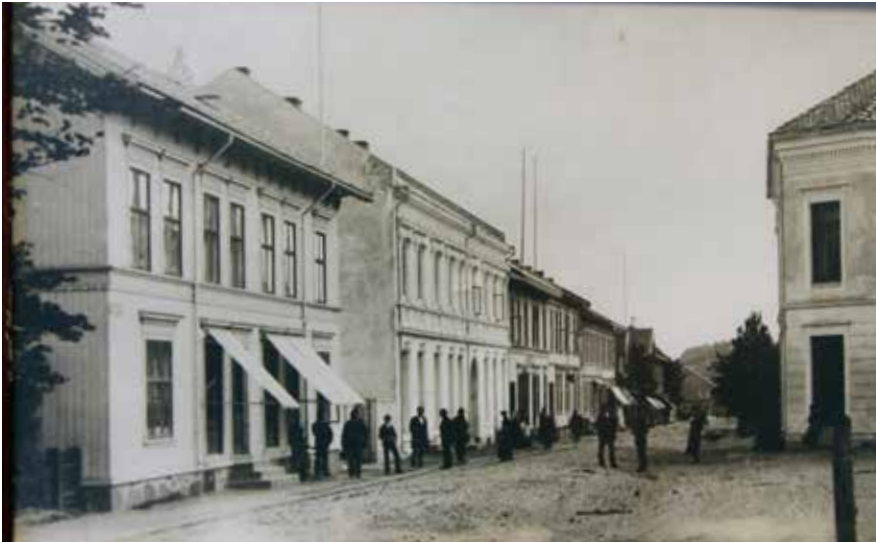
Storgaten sett nedover mot torvet. Sperregården til venstre. Borgegården. Foto tatt før brannen i 1900.
